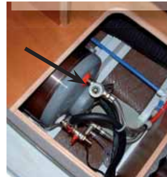
ROBINET THERMOSTATIQUE DE CHAUFFE-EAU
