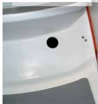
ORIFICE DE DECHARGE D'EXTINCTEUR
