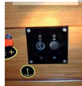
DISJONCTEUR DU GUINDEAU
